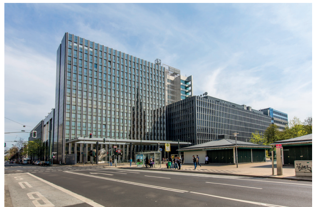
Das 13-stöckige Gebäude des Innenministeriums Nordrhein-Westfalen in der Außenansicht; Foto: Jochen Tack
